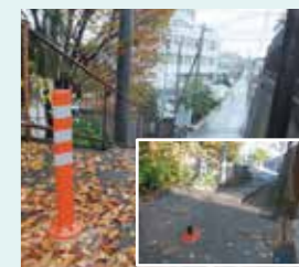
どんぐり山安全ポールの補修
