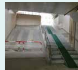
本太地下道の改修
